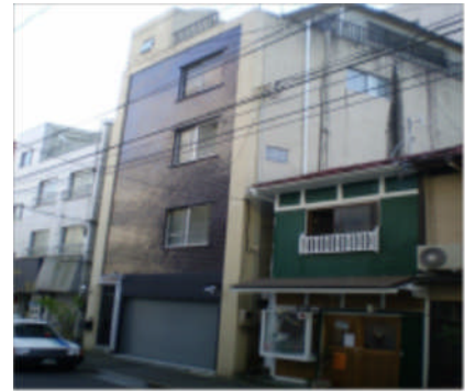
【撤去した暴力団事務所】
